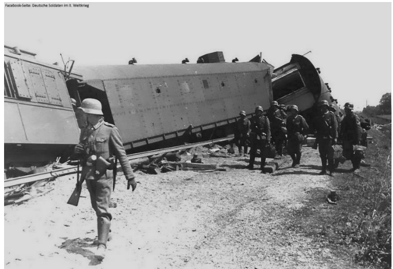
Russland 1942: Sowjetische Partisanen haben die Gleise einer Bahnstrecke in die Luft gejagt und dadurch einen Wehrmachtzug zum Entgleisen gebracht.
